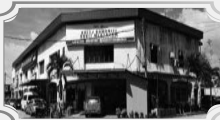
Bangunan di Bukit Mertajam, Pulau Pinang
