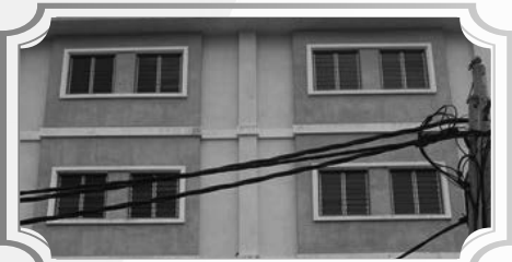
Bangunan di Teluk Intan, Perak
